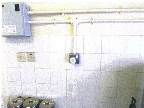
PVC Conduit Installation
